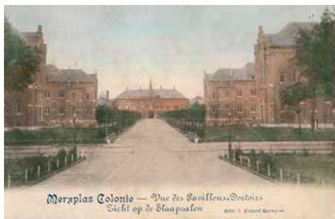
De vier landlopersslaapzalen van Merksplas-Kolonie (voorground), nu onderdeel van het 'Centrum voor Illegalen van Merksplas', en op de achtergrond de hoofdingang van Merksplas-Kolonie (afbeelding: Gevangenis-museum).
